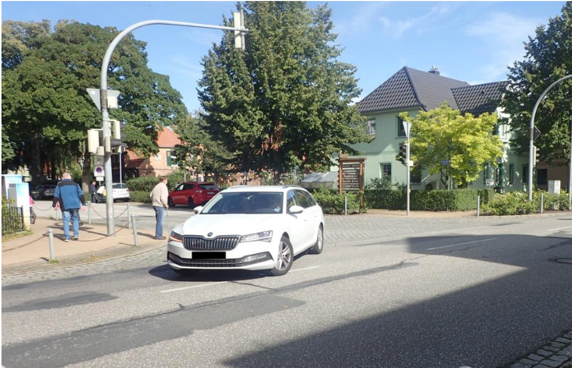
Abbildung 14: Lokaler Lärmschwerpunkte: Grobes Pflaster im Kreuzungsbereich Strandstraße/L 21
